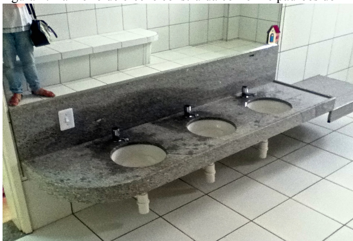
Figura 2: Banheiro de creche construída conforme padrões do MEC.
