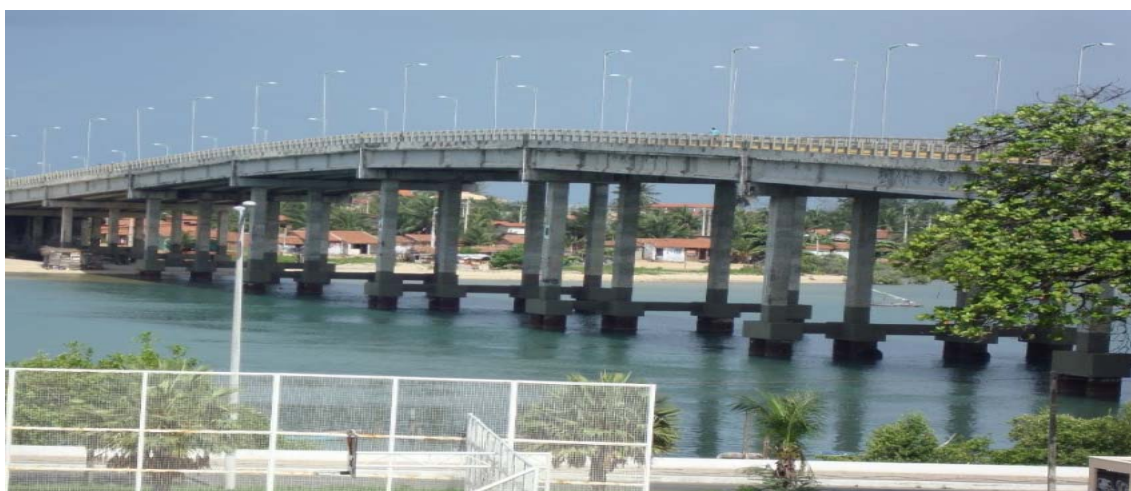
Figura 6 – Ponte do Rio Ceará
