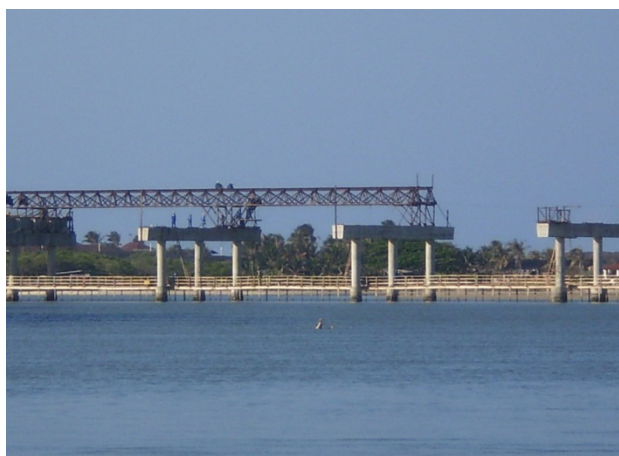
Construção da Ponte no Rio Cocó. Fevereiro de 2009
