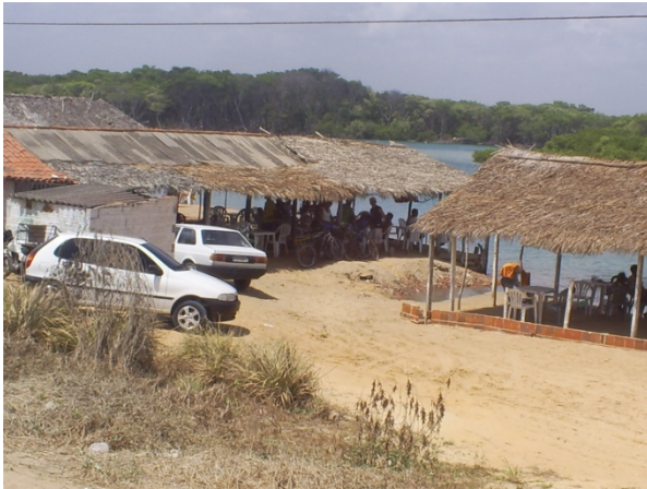
Barracas na margem do rio Cocó, ocupação no espelho de água (APP)
