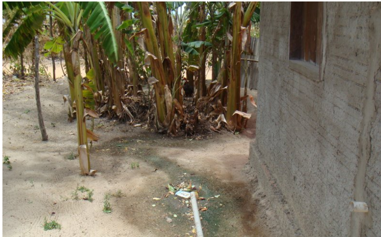
Figura 4 - Reúso informal das águas cinza em residência na comunidade Vila Tomé, Aquiraz, – CE, 2009.
