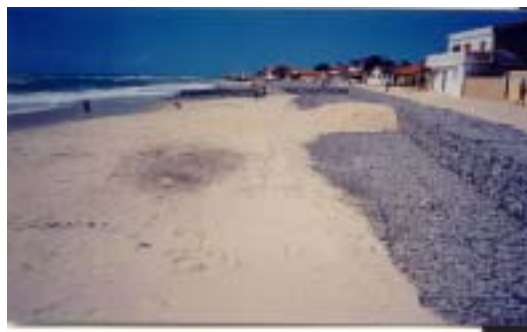
Figura 4 – Vista da construção do muro protetor com o colchão.
