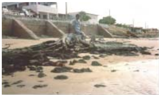
Figura 2 – Muro construído para impedir o avanço do mar.
