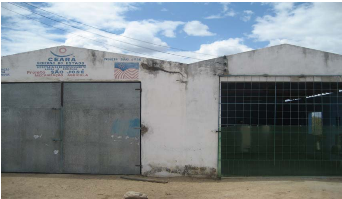
FIGURA 11: Prédio da associação e abrigo do tanque de resfriamento. Fotografia: Anderson Rodrigues, set/2008.
