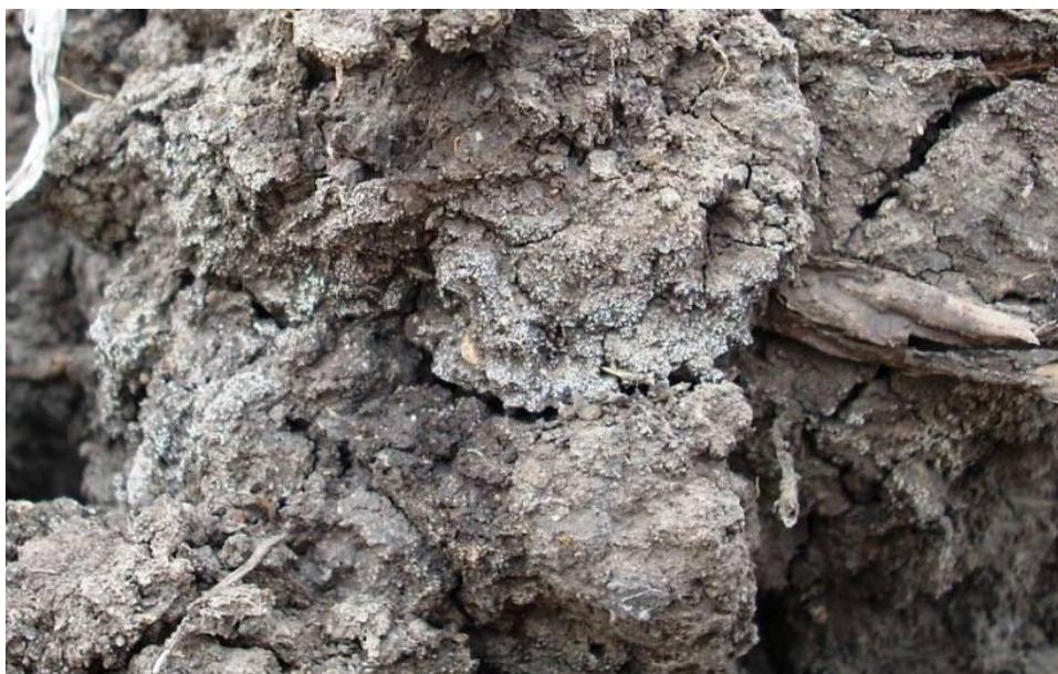
Figura 3: Eflorescência salina em Vertissolo localizado no Baixo Acaraú-CE (Foto do autor).
