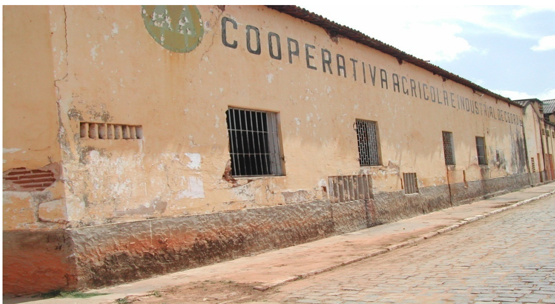
Figura 19 – Prédio da COCEDRO no centro do município. Fotógrafo: José César P.Moreira, dez/2007.
