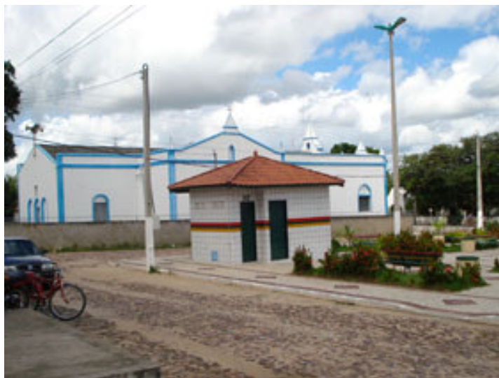
Foto 25 – Banheiro fechado próximo à feira de Ocara
