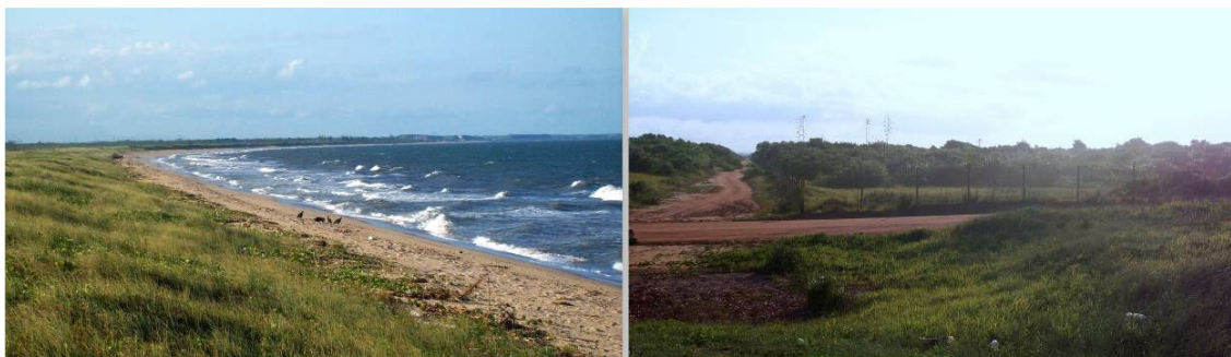
Fotos 29 e 30 – Local previsto para serem instalados o porto e a indústria siderúrgica
