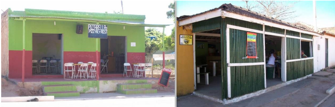
Fotos 14 e 15 – Infra-estruturas de restauração na praia de Marobá.
