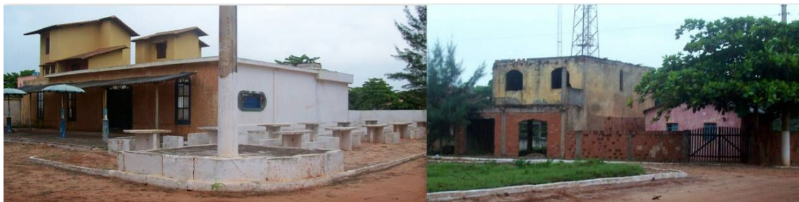
Fotos 10 e 11 – Construções praticamente abandonadas na Praia das Neves
