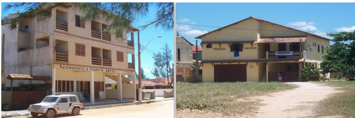
Fotos 16 e 17 – Infra-estruturas de restauração e hospedagem na Praia das Neves
