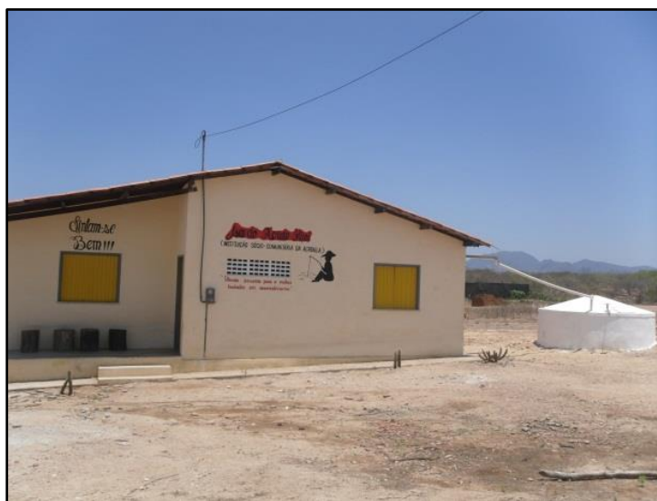
Figura 13: Cisterna de placa na Agrovila do Açude Missi.
