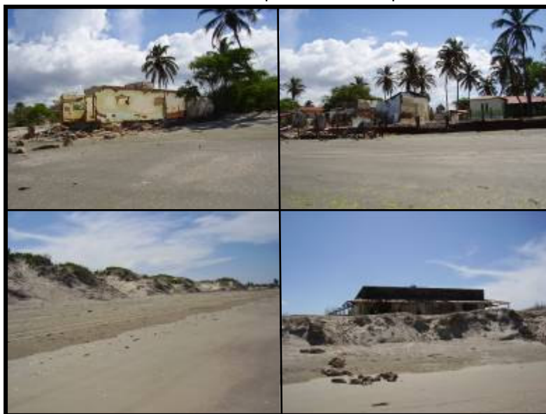
Figura 39 – Evidências de erosão na faixa de praia do município de Grossos.
