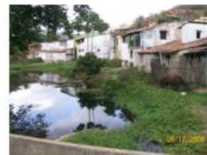
Figura 07: ocupação desordenada da planície de inundação.
