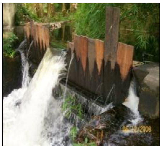
Figura 39:barramento no canal principal do rio Pacoti; Figura 40:“levadas”, canais artificiais para irrigação
