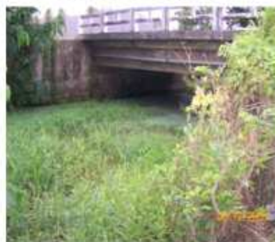
Figura 04: Canalização de afluentes.
