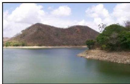
Figura 14: Vista parcial do açude Acarape do Meio
