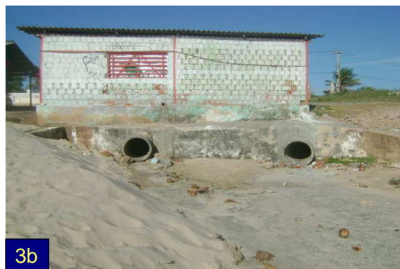
Figura 3 - Emissário submarino de Fortaleza (3a) e galerias pluviais usadas para o escoamento de esgotos (3b, 3c, 3d, 3e, 3f, 3g e 3h) no litoral oeste de Fortaleza.
