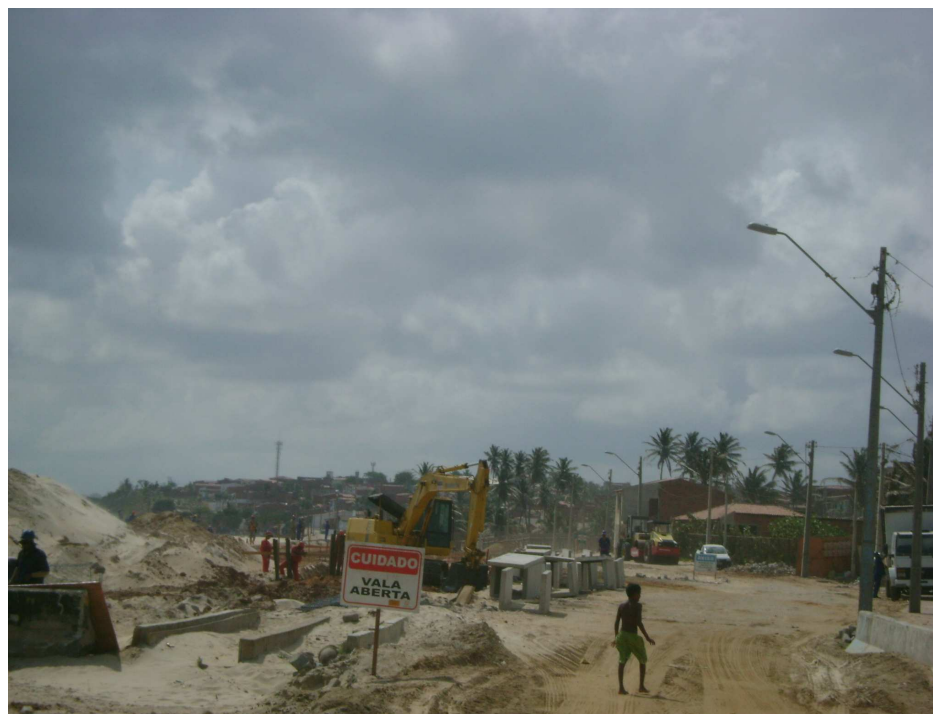
Figura 11 - Aspecto da intervenção urbana na costa oeste de Fortaleza, destacando-se a implantação de uma rede de coleta de esgoto e a construção do calçadão e via paisagística.
