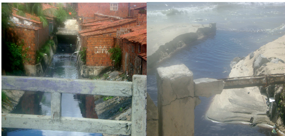
Figura 1 - Aspecto de galeria pluvial utilizada para descarga de efluentes domésticos lançados no mar provenientes de casebres, Praia das Goiabeiras, Fortaleza, Ceará.
