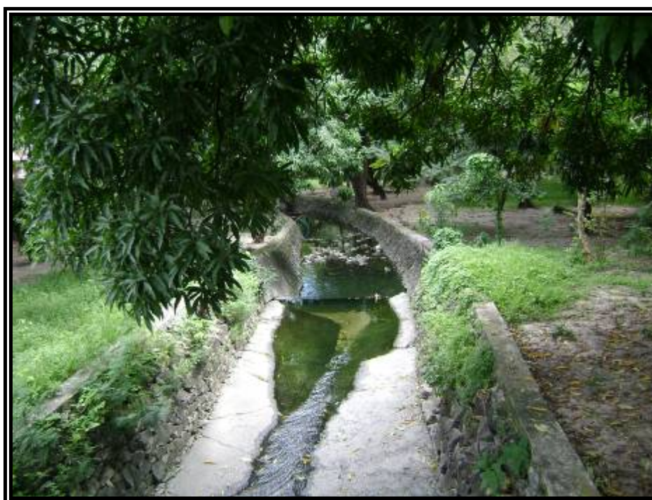
Figura 54 - Rio Pajeú canalizado localizado no Paço Municipal de Fortaleza. Foto: Mônica Pinheiro (Maio/2009).
