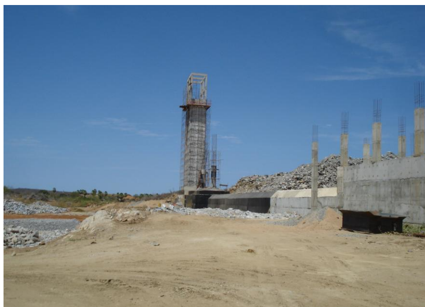
Figura 4: Construção do barramento do Rio Figueiredo em Alto Santo.
