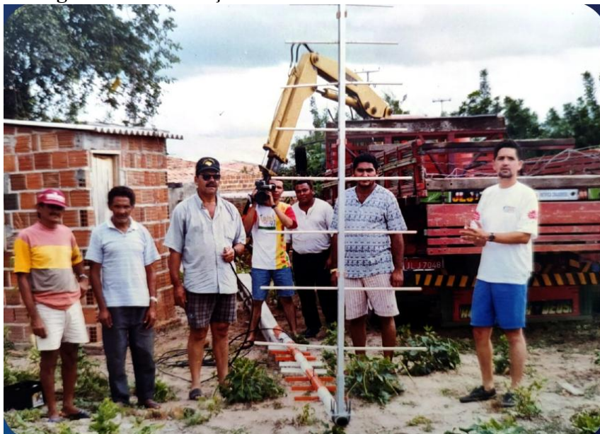
Figura 32 – Instalação da antena no Horto do Padre Cícero
