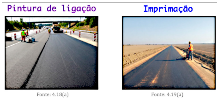
Figura 4.18 – Visualização da aplicação da pintura de ligação e da imprimação em campo
