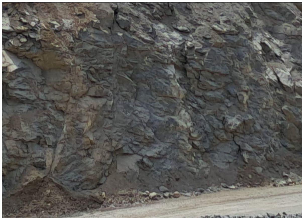
Figura 18: Maciço rochoso fraturado
