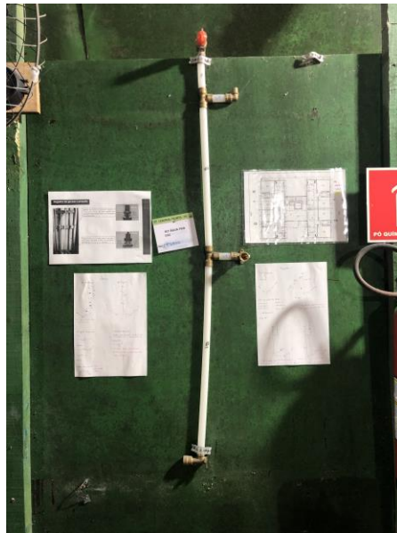
Figura 13 – Exemplo de Kit de Água Fria de Cozinha
