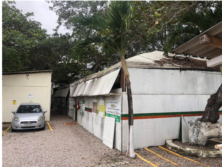
Figura 10 - Fábrica de Kits de Instalações Prediais
