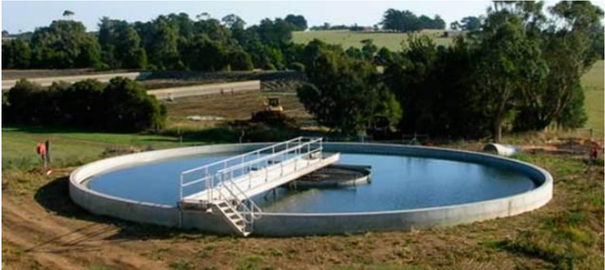
Figura 1: Tanque de sedimentação
