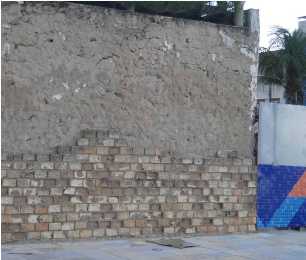
Figura 9 – Muro que será utilizado pela construtora inventada ( J. Naquin ).
