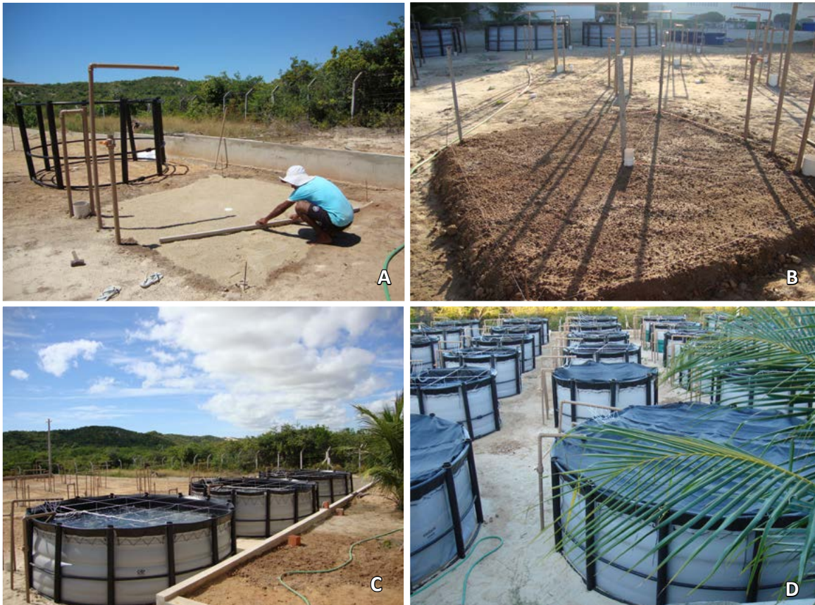
FIGURA 3.7. Nivelamento do solo para instalação dos tanques de lona foi realizado com areia fina (A) ou arisco (B). Tanques berçários após a instalação (C) e sistema de cultivo finalizado (D).
