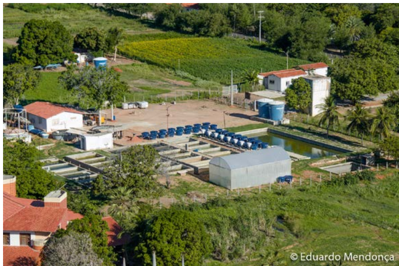
FIGURA 7.1. Setor de Aquicultura da Universidade Federal do Semi-Árido (UFERSA) onde a pesquisa foi realizada. A foto mostra viveiros experimentais de alvenaria com fundo de terra e tanques circulares de 1 m 3 utilizados no estudo. Foto: Eduardo Mendonça.
