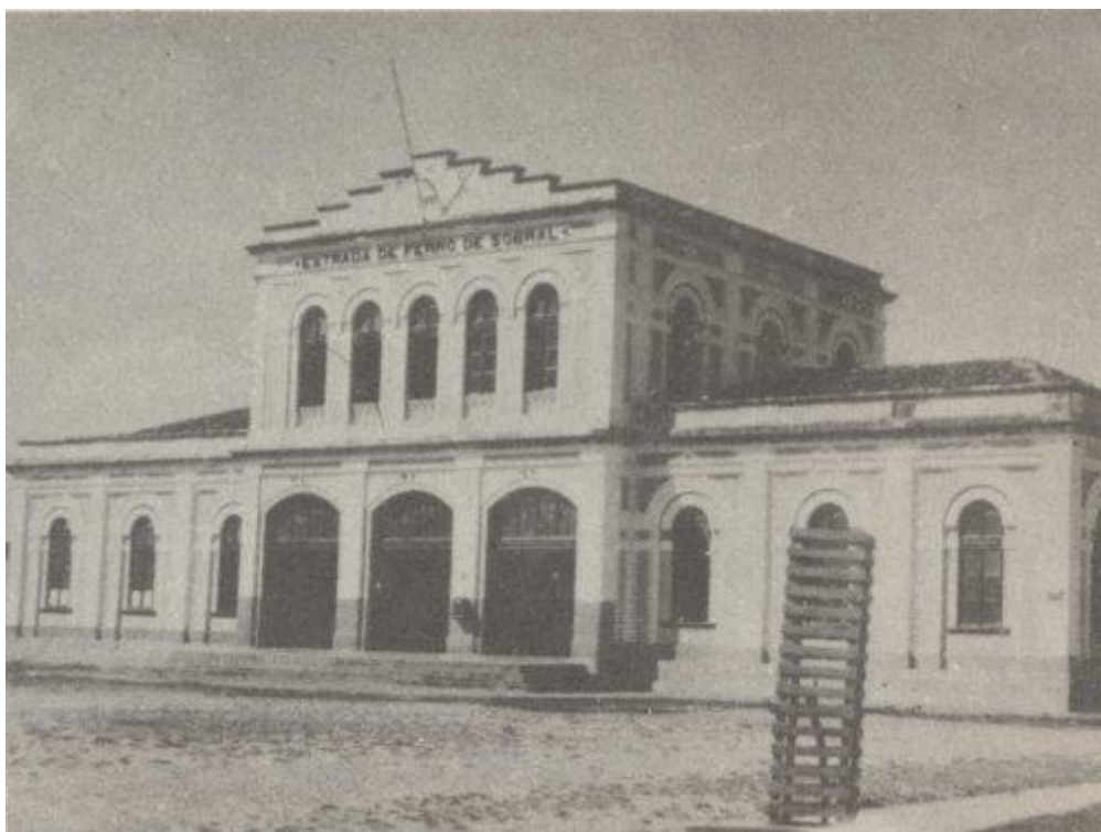
Figura 45 - Estação Ferroviária de Camocim.
