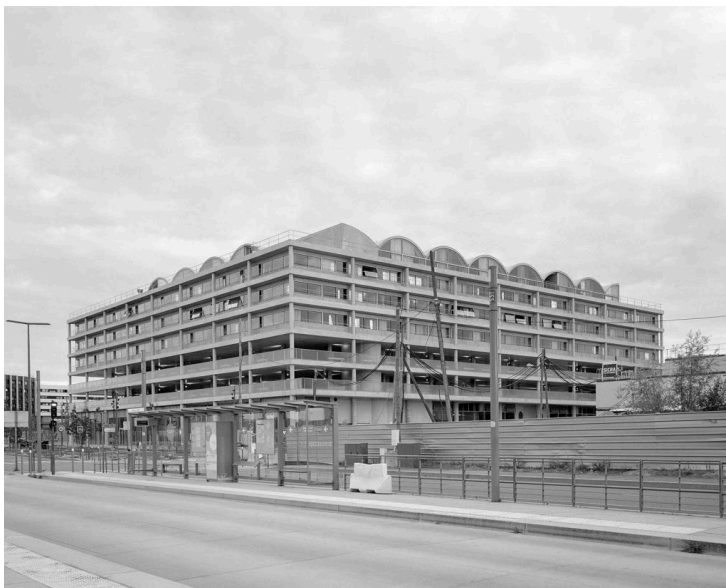
Figura 17. Vista externa da edificação. Fonte: Bruther, Maxime Delvaux.
