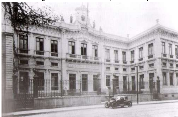
Figura 3: Fachada da Escola da Freguesia de N. Sra. da Glória, um dos exemplares do Colégio do Imperador.
