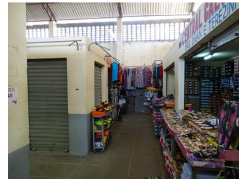
Figura 43: Corredor interno produtos expostos na área externa dos Boxes, e diversos Boxes sem funcionamento. Fonte: Prefeitura de Limoeiro do Norte
