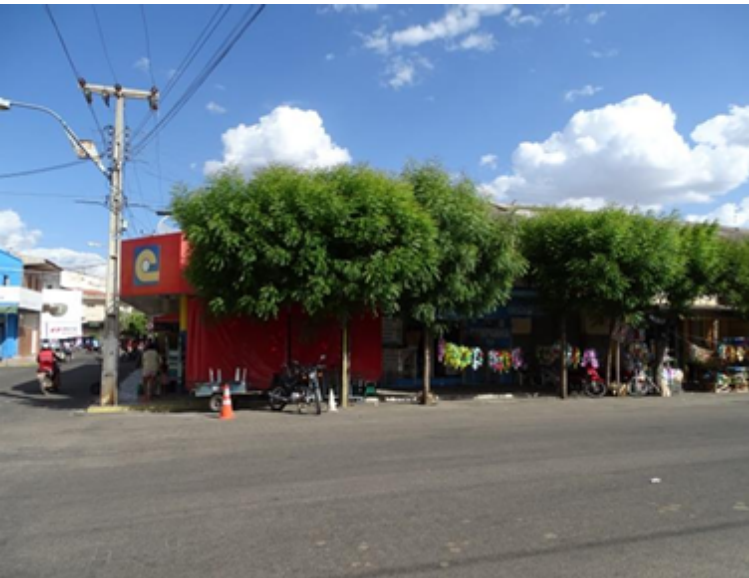
Figura 40: Fachada oeste voltada para a Av. Dom Aureliano Matos parcialmente encoberta por árvores e produtos. Fonte: Prefeitura de Limoeiro do Norte
