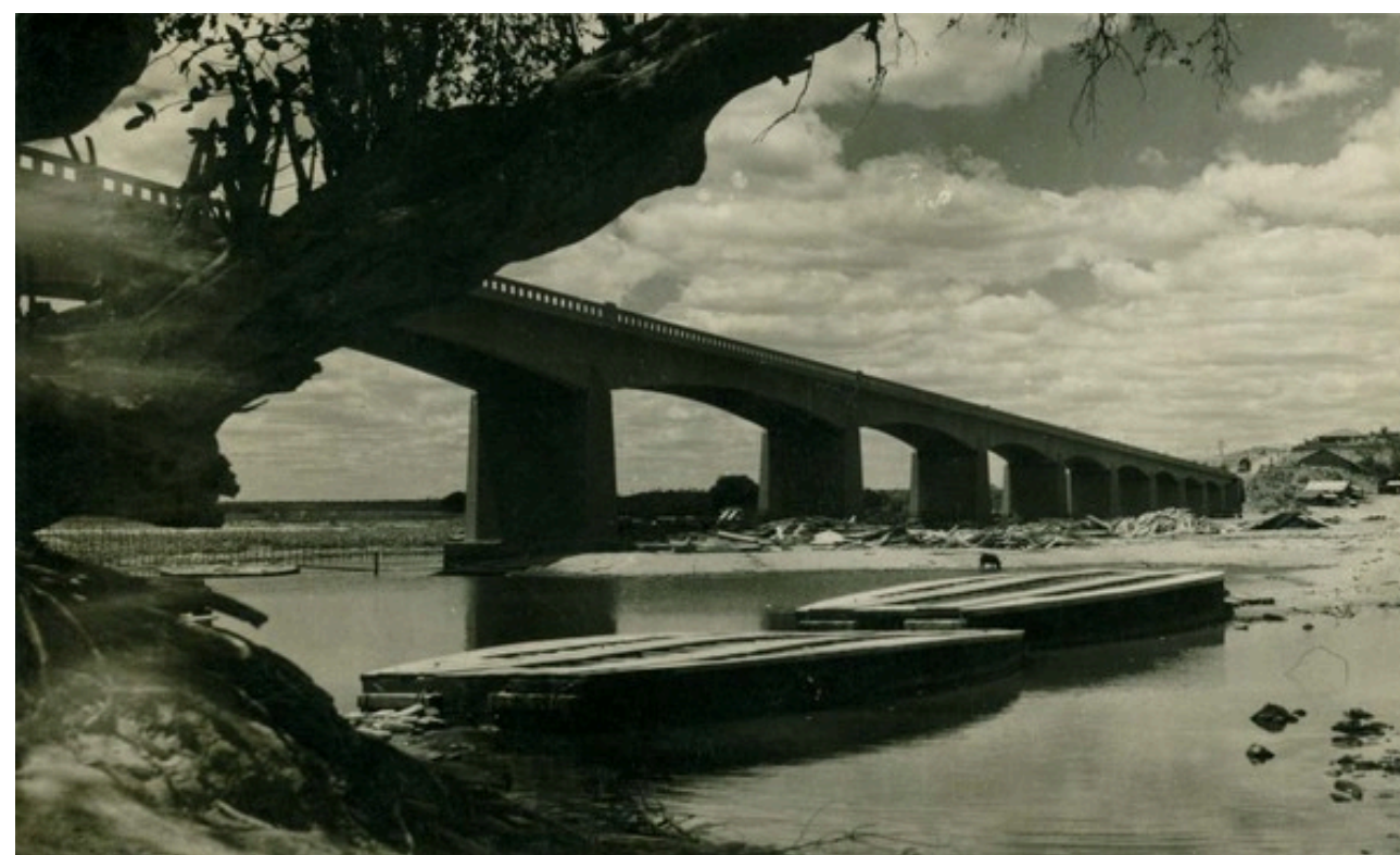
Figura 01: Ponte sobre o Rio Jaguaribe : Limoeiro do Norte, CE - [19--] Fonte: IBGE
