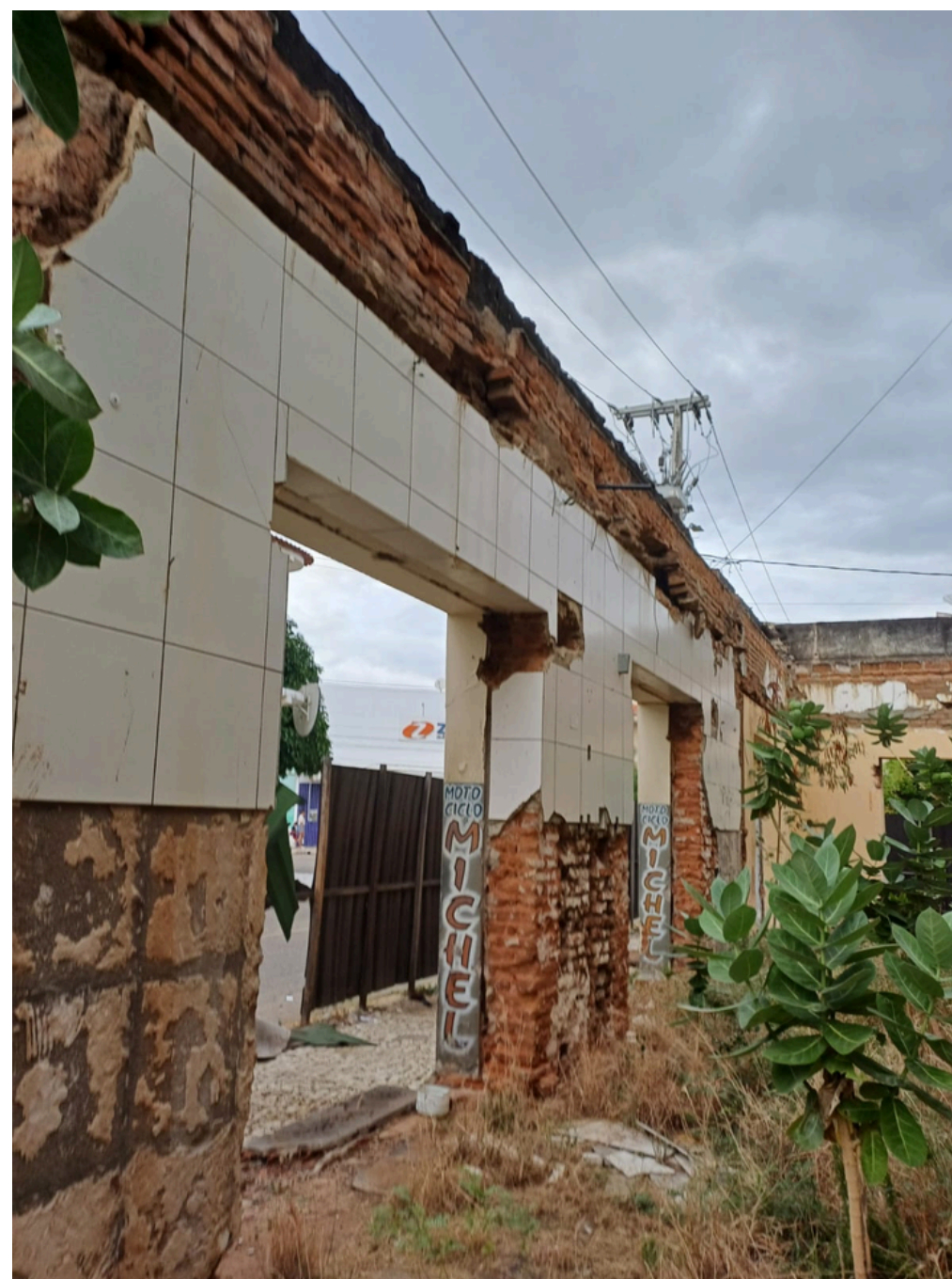
Figura 48: Parte interna da fachada norte Fonte: Acervo do autor
