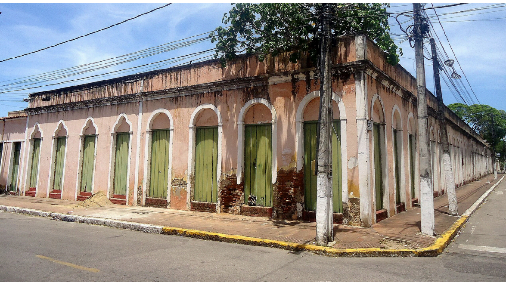
Figura 18: Foto externa do mercado Fonte: Wikipédia
