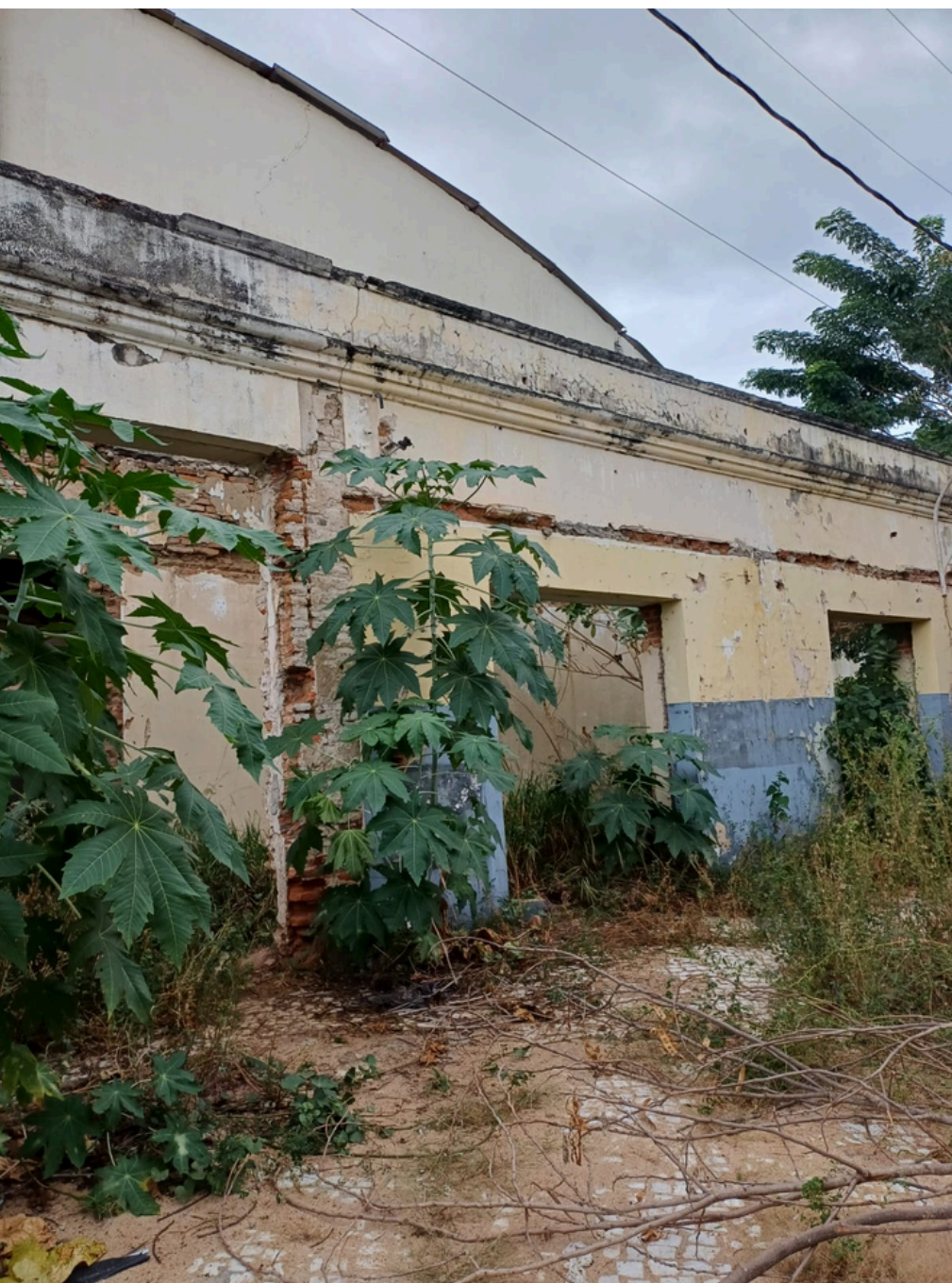
Figura 47: Fachada sul Fonte: Acervo do autor
