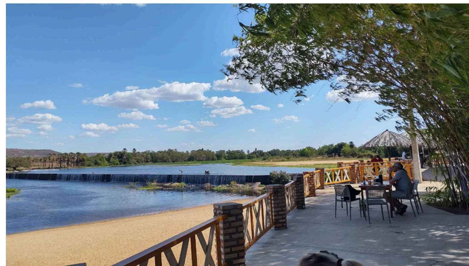
Figura 10: Vista panorâmica da Barragem das Pedrinhas Fonte: Google Maps
