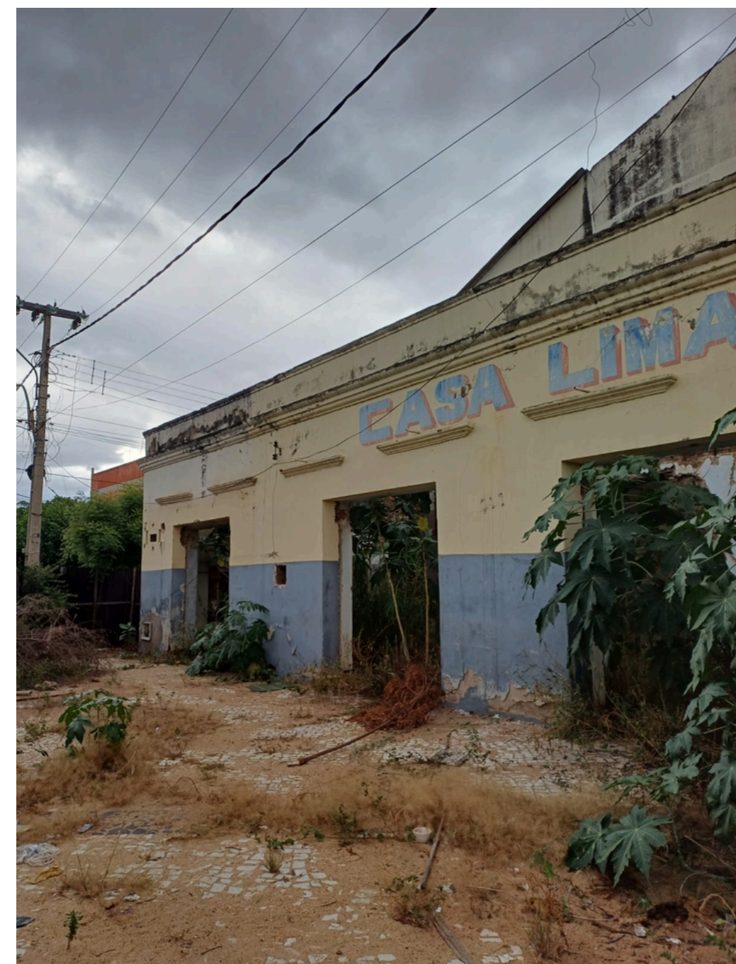
Figura 49: Fachada sul Fonte: Acervo do autor
