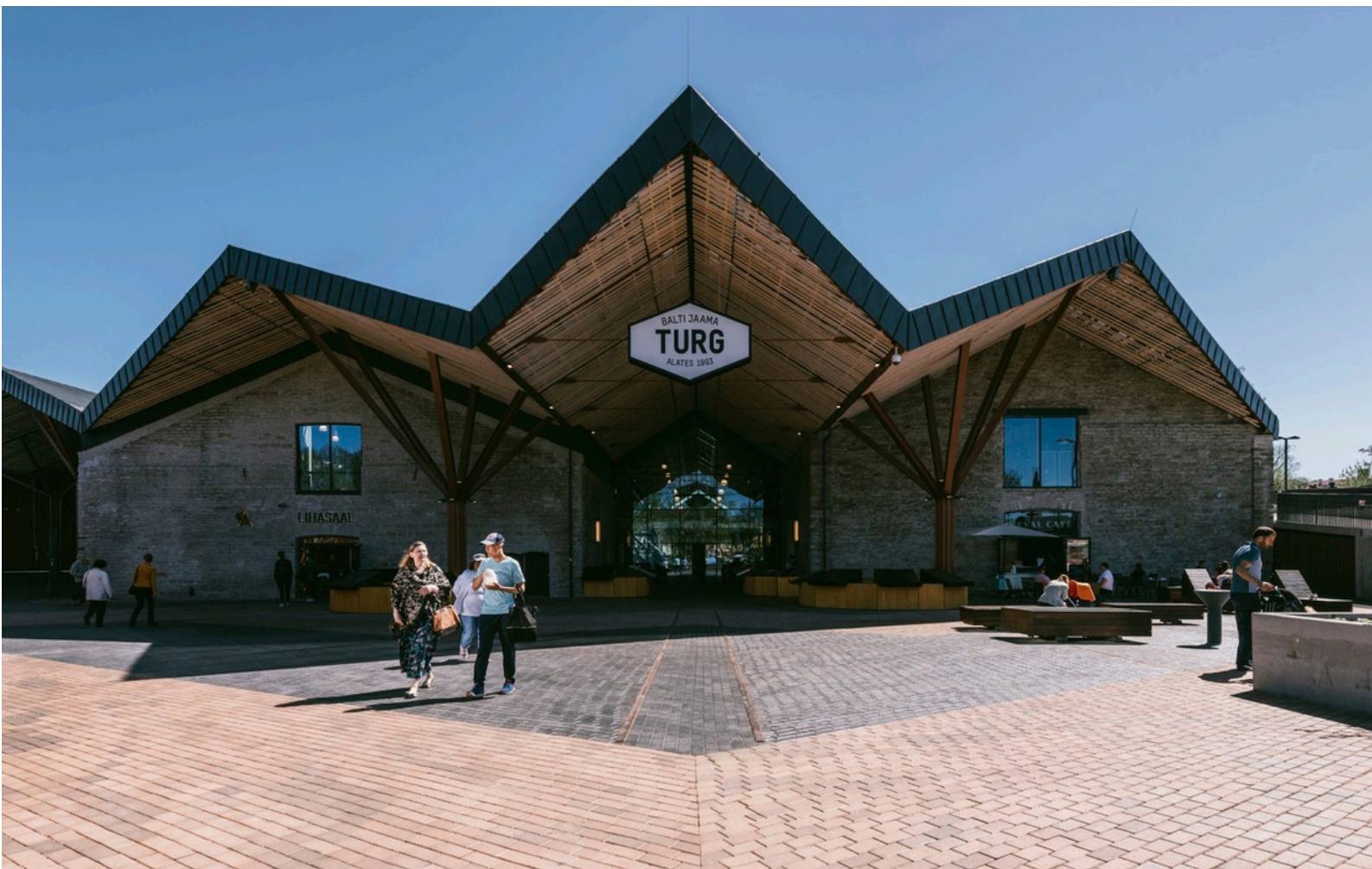
Figura 25: Foto externa do mercado Fonte: Archdaily
