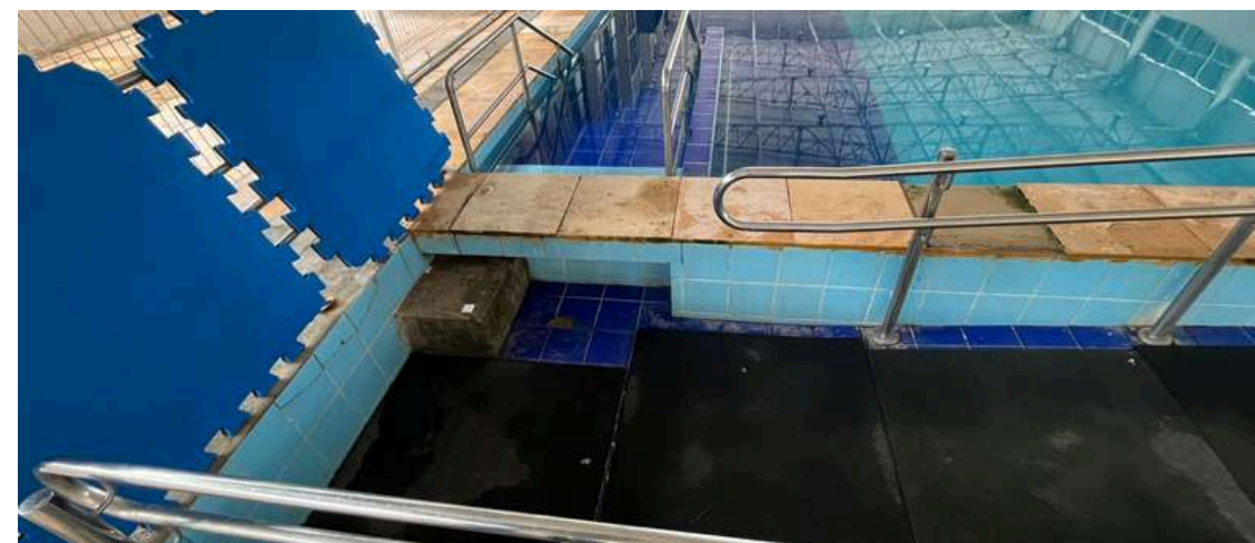
Figura 6: Rampa de acesso à piscina.
