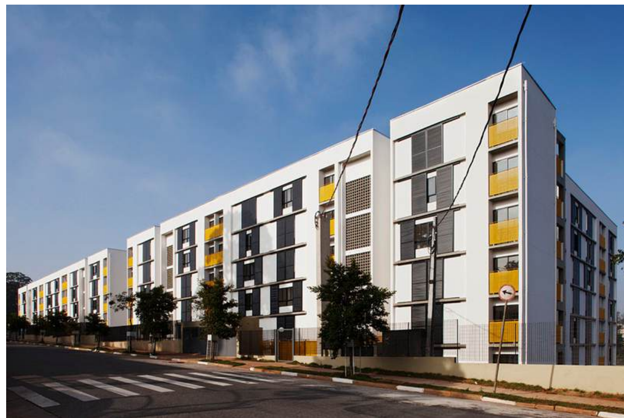
Figura 22: Vista geral do Residencial Corruíras. Fonte: Archidaily.
