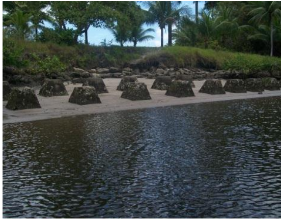
Figura 16. Poitas de concreto utilizadas na ancoragem da balsa e do espinhel.
