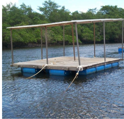
Figura 14. Balsa de apoio ao cultivo com área construída de 24 m 2 .
