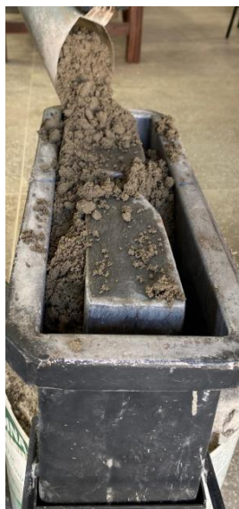
(a) Moldagem dos blocos em fôrmas
