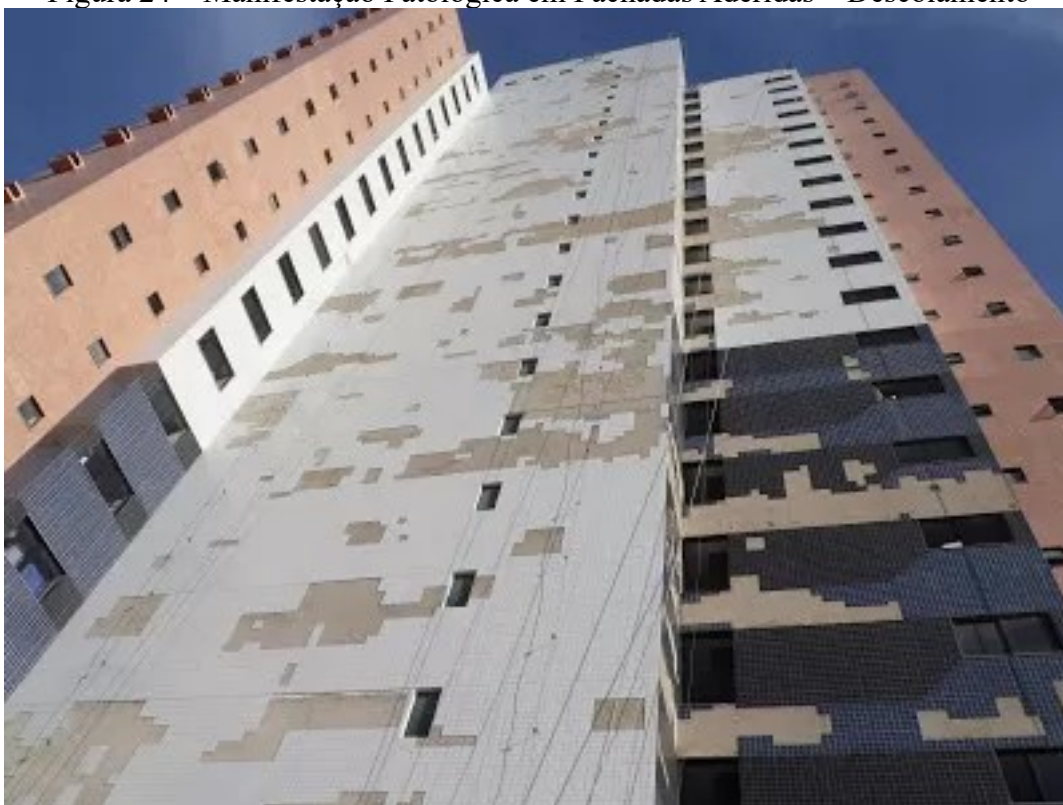
Figura 24 – Manifestação Patológica em Fachadas Aderidas – Descolamento
