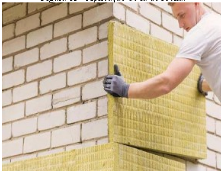
Figura 13 - Aplicação de lã de rocha.
