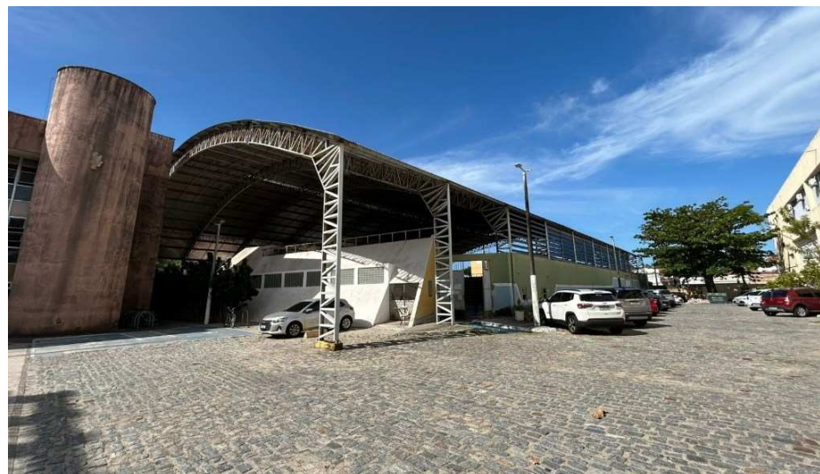
Figura 4: Fachada do bloco Quadra do CEU.
