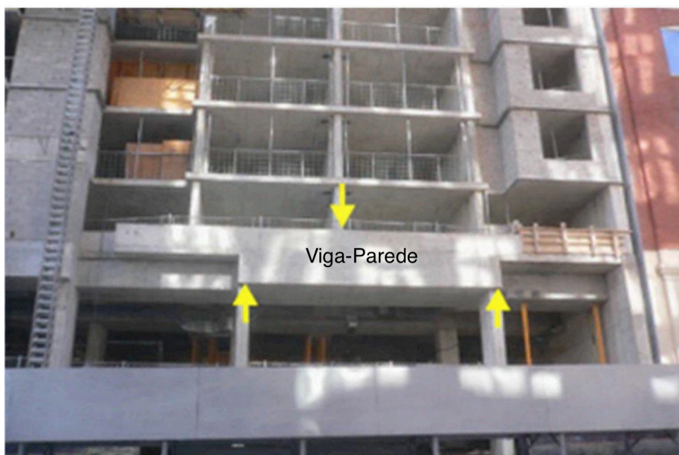
Figura 1 – Aplicação de viga-parede em edifício de vários pavimentos
