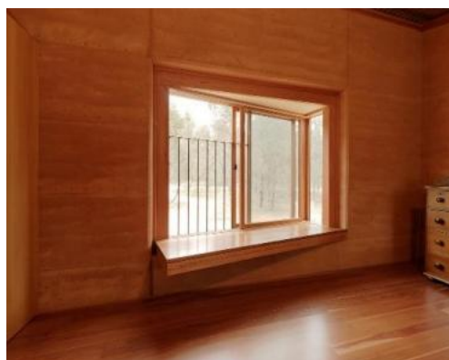
Figura 7 - Paredes executadas de taipa em uma edificação moderna
