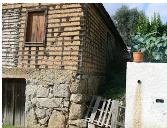
Figura 3 - Habitação antiga com parede exterior em pedra no piso inferior, seguida de parede em tabique no andar superior
