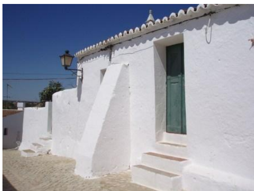
Figura 6 - Contraforte construído em uma casa feita de taipa
