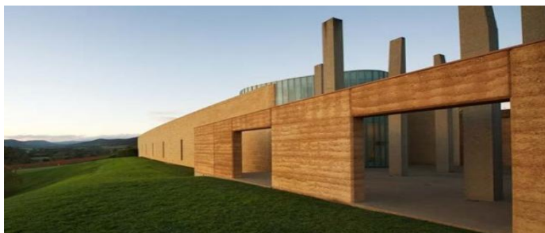
Figura 1 - Edificação construída com terra crua
