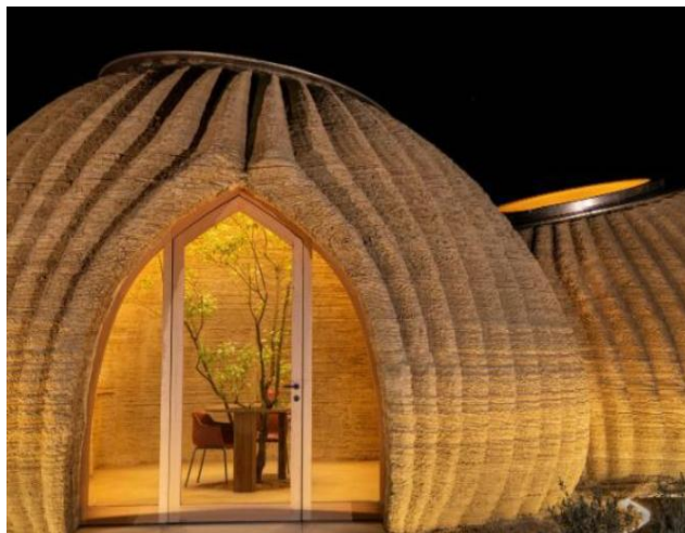
Figura 12 - Edificação de terra crua construída por impressão 3D
