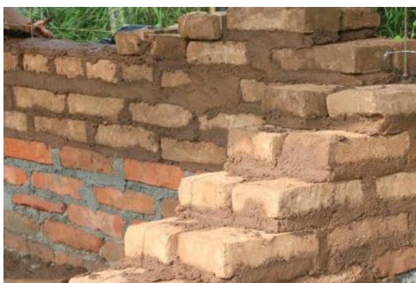
Figura 9 - Construção de paredes em adobe, sobre uma fundação em tijolo cerâmico
