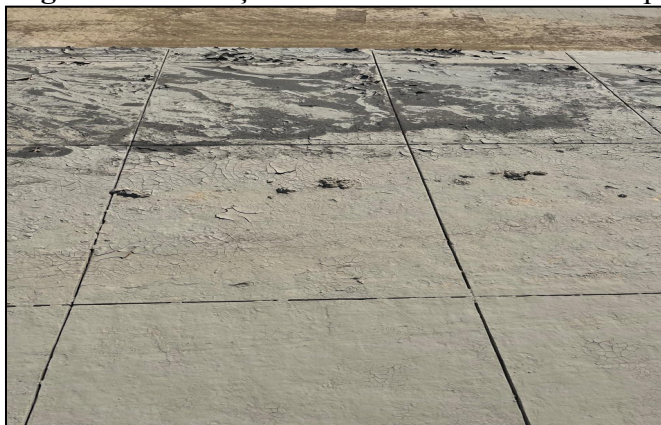
Figura 1 - Marcação da retirada dos ladrilhos de pedra morisca
