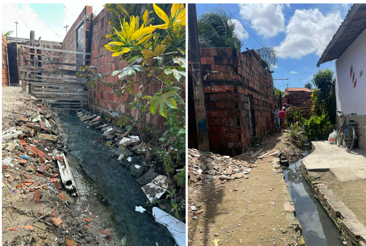
Figuras 33 e 34 - Construção de valas para escoamento de águas pluviais e servidas
