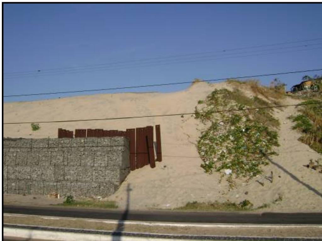
**Figura 88: Foto de muro de contenção construído para tentar barrar a migração da Duna da Barra do Ceará (Foto: Mônica Virna, Setembro de 2007).**
