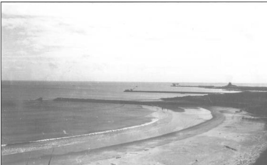
**Figura 90: Foto da enseada do Mucuripe, com molhes costeiros construídos para reter a ação das ondas (Fonte: Acervo Nirez).**
