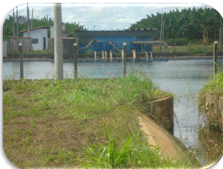
Figura 24 - Foto: Sistema de irrigação – Reservatório de água, 2009. Fonte: Acervo da pesquisa
