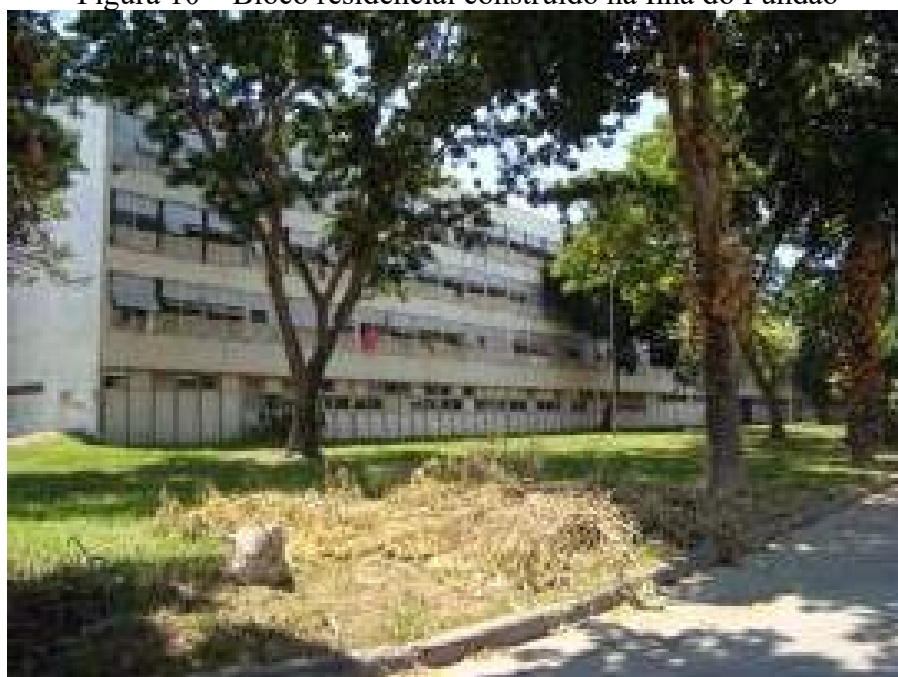
Figura 10 – Bloco residencial construído na Ilha do Fundão
