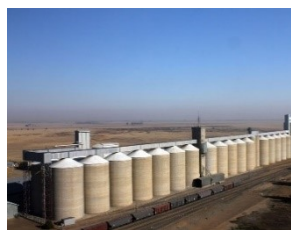
Figura 3 : exemplos de obras as quais o Eurocode 8 obriga a consideração dos efeitos de Interação Solo-Estrutura no dimensionamento estrutural.
