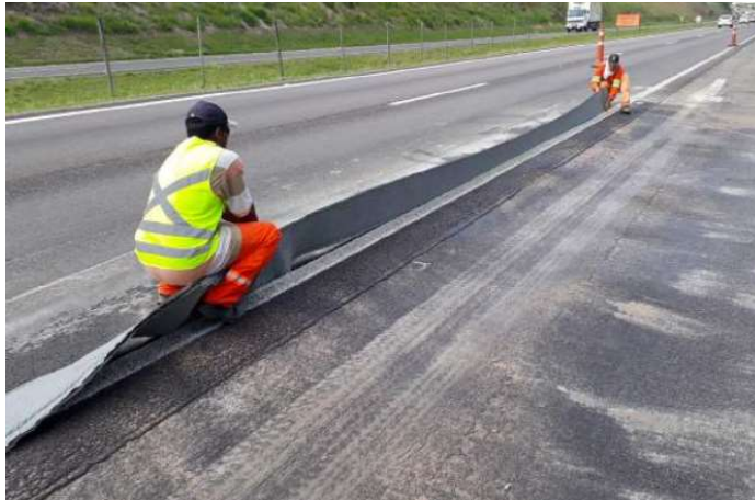
Figura 27 - Drenagem de pavimento em microvala com geocomposto
