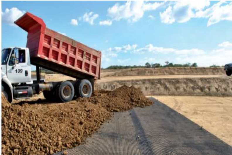
Figura 34- Reforço de base de pavimento com geogrelha
