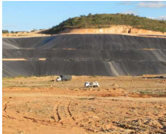
Figura 22 – Impermeabilização de aterro sanitário com geomembranas
