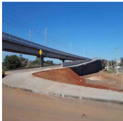
Figura 40 – Obra finalizada com uso da geogrelha e microgrelha
