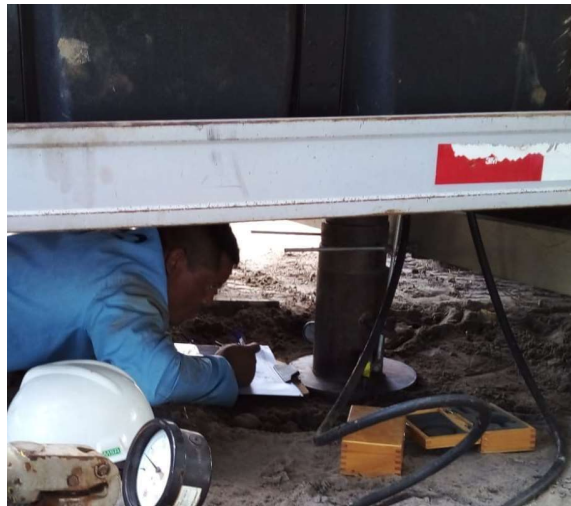
Figura 67- Execução da PCE2
