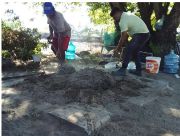
Figura 58 – correção da umidade do solo de cada camada
