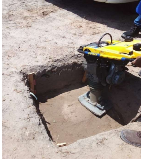
Figura 59 – compactação das camadas de solo
