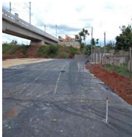
Figura 39 – Microgrelha e geogrelha aplicada em solo de baixa capacidade de suporte
