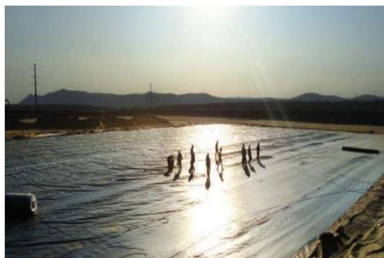
Figura 23- Impermeabilização de lagoa de tratamento com geomembrana
