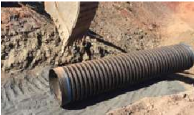
Figura 31 - Representação dos geotubos corrugados
