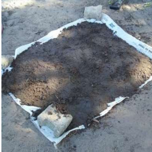
Figura 63 – proteção da cava de solo compactado
