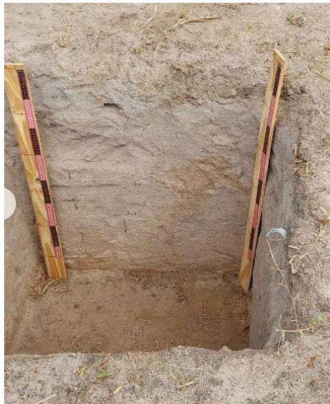
Figura 60 – controle da altura das camadas de solo compactado
