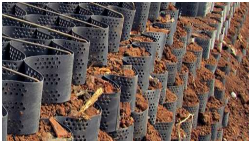
Figura 30- Representação da Geocélula PEAD com parede perfurada.
