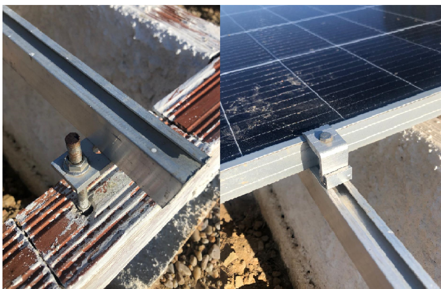
Figura 18 - Estrutura de fixação dos módulos
