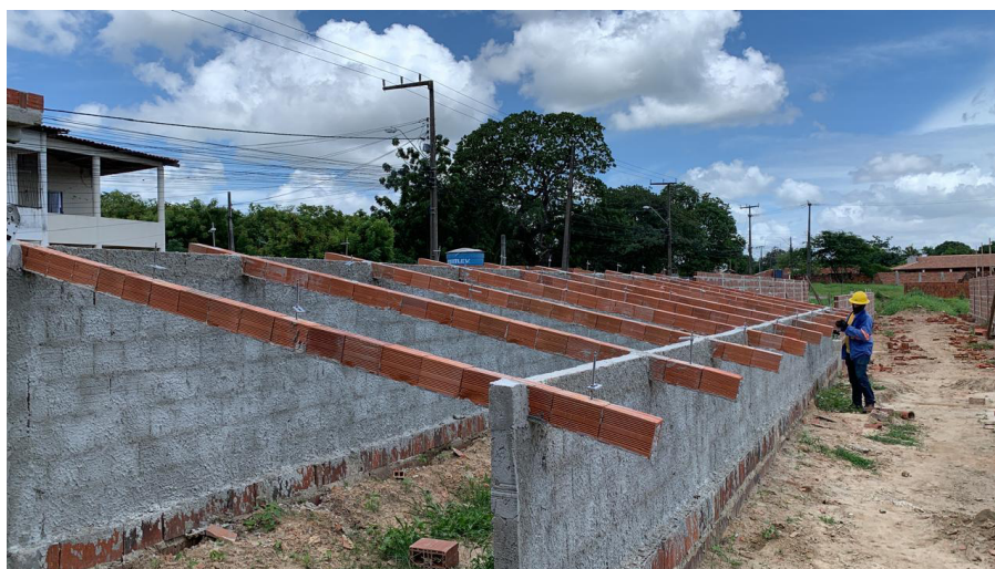
Figura 17 - Base para a estrutura de fixação dos módulos.
