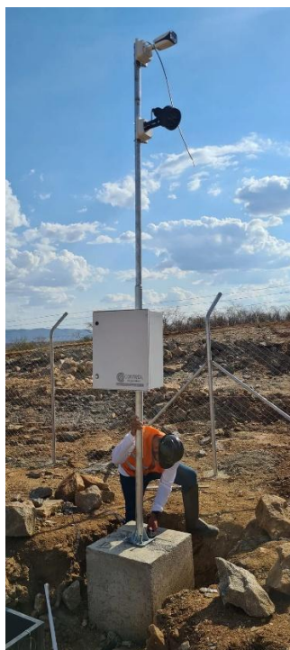
Figura 17 - Instalação de um poste de CFTV com câmera e Sirene
