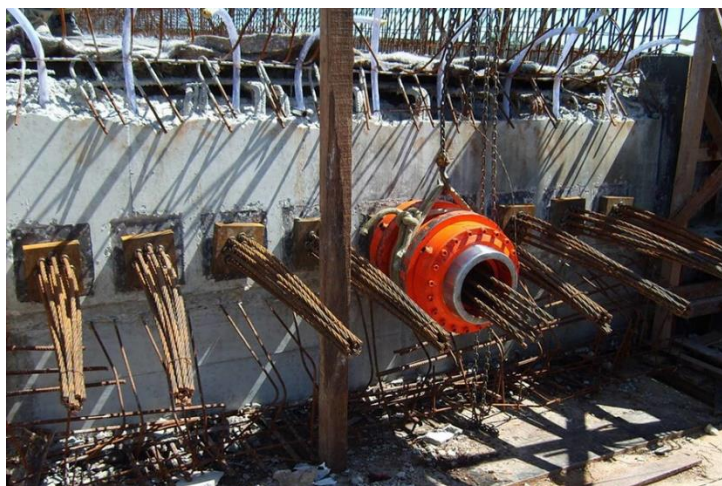
Figura 3 - Protensão com aderência posterior.
