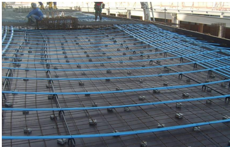
Figura 4 - Protensão não-aderente.
