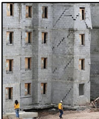
Figura 25: Patologia causada devido recalques no radier
