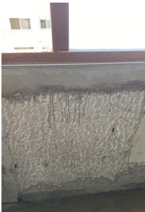
Figura 7 – Exemplo de perda por Making-do : regularização da parede após assentamento de esquadria.
