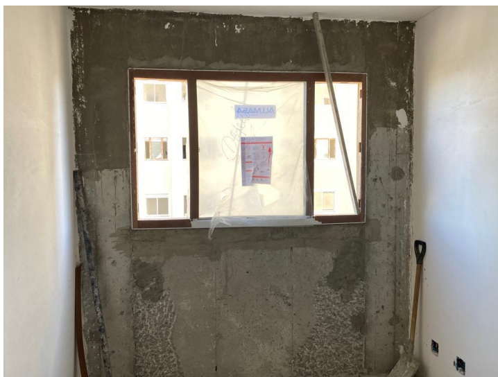
Figura 6 – Exemplo de perda por Making-do : regularização da parede após assentamento de esquadria.
