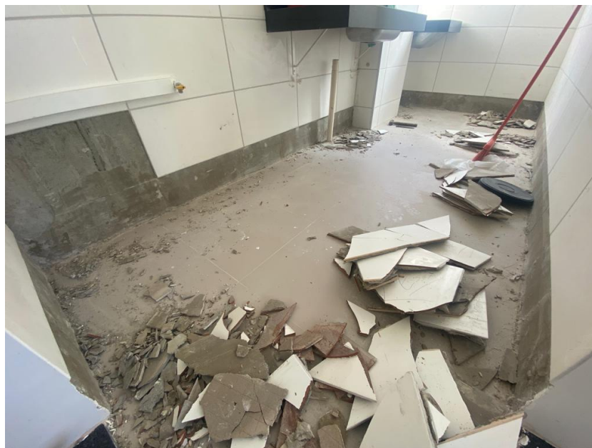
Figura 20 – Exemplo de perda por Making-do : azulejo com som cavo.
