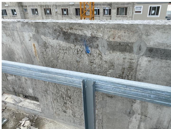
Figura 10 – Exemplo de perda por Making-do : estrutura do telhado interferindo nos pontos de ancoragem dos balancins
