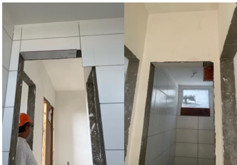
Figura 11 – Exemplo de perda por Making-do : cerâmica não recortada no vão da porta por falta de maquia durante execução.
