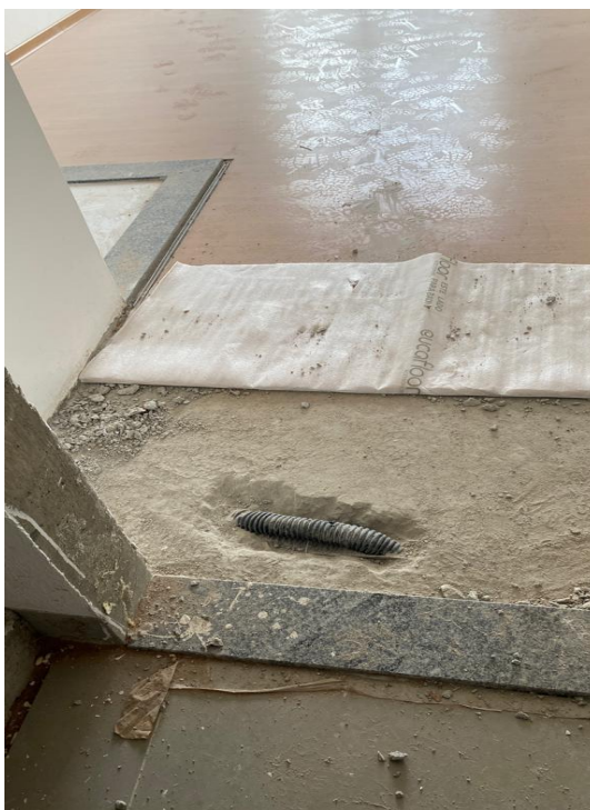
Figura 12 – Exemplo de perda por Making-do : assentamento do piso laminado começou sem a finalização da regularização da laje.
