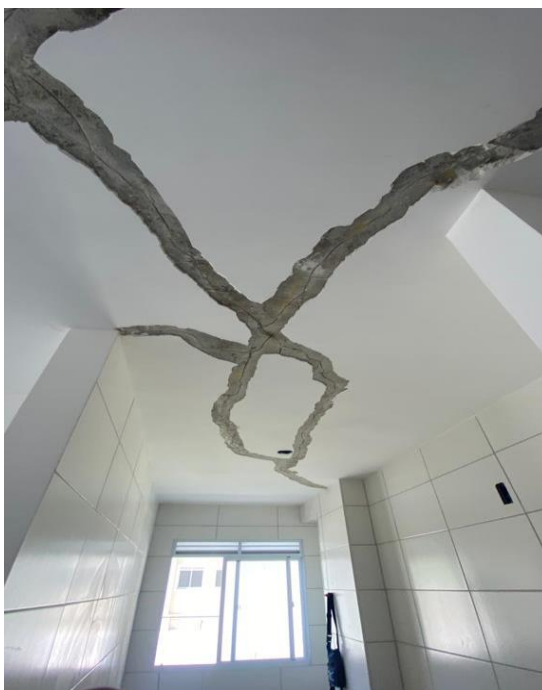
Figura 21 – Exemplo de perda por Making-do : Pintura refeita devido o tratamento de fissuras.
