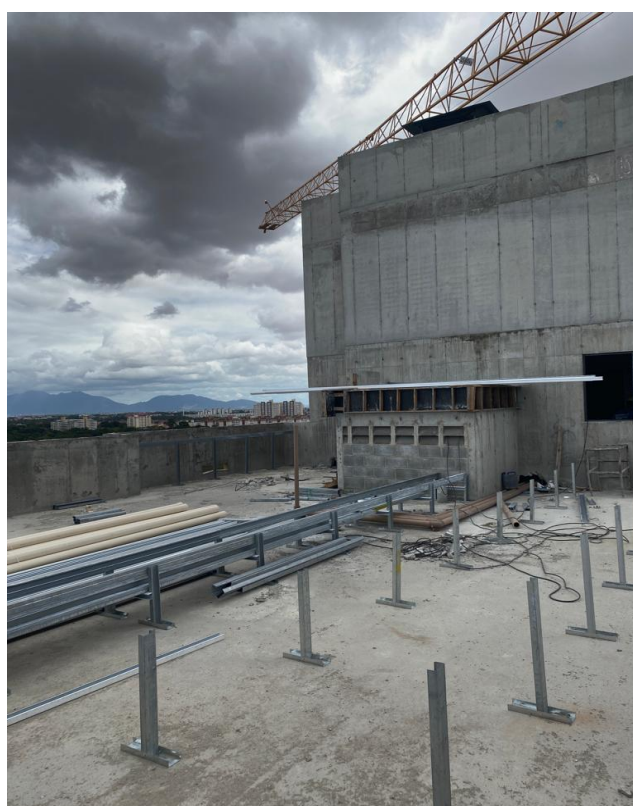
Figura 9 – Exemplo de perda por Making-do : estrutura do telhado interferindo nos pontos de ancoragem dos balancins.
