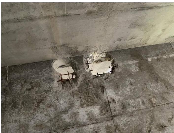
Figura 8 – Exemplo de perda por Making-do : passagens de prumadas de incêndio não seguiram o projeto.
