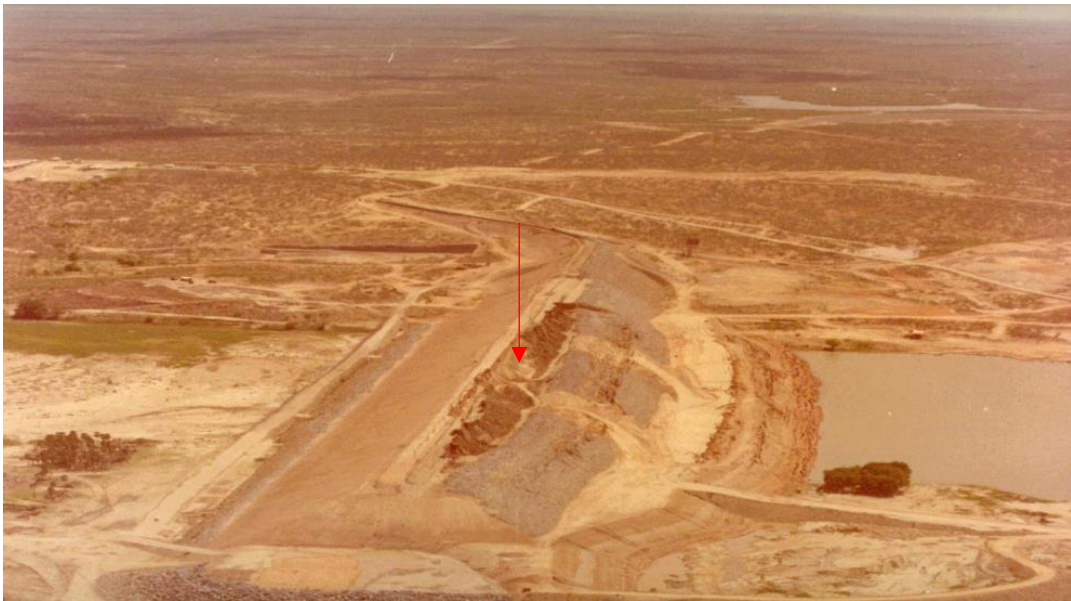
Figura 11 – Vista superior da ruptura da Barragem de Açú em 1981
