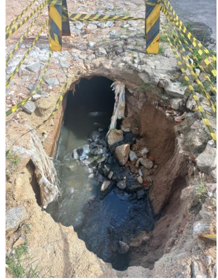
Figura 29- Abertura de cratera no pavimento na rua Irapuã Vidal.
