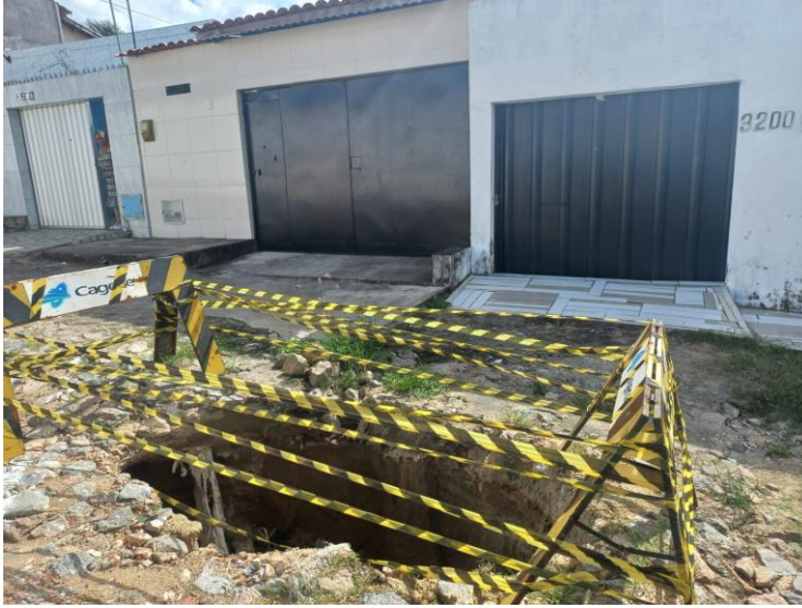
Figura 29- Abertura de cratera no pavimento na rua Irapuã Vidal.
