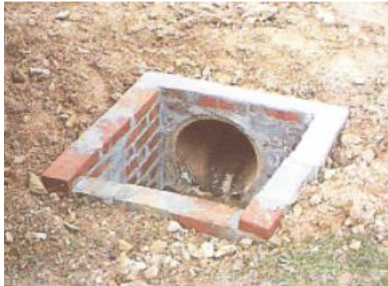
Figura 8 – Caixa coletora em alvenaria
